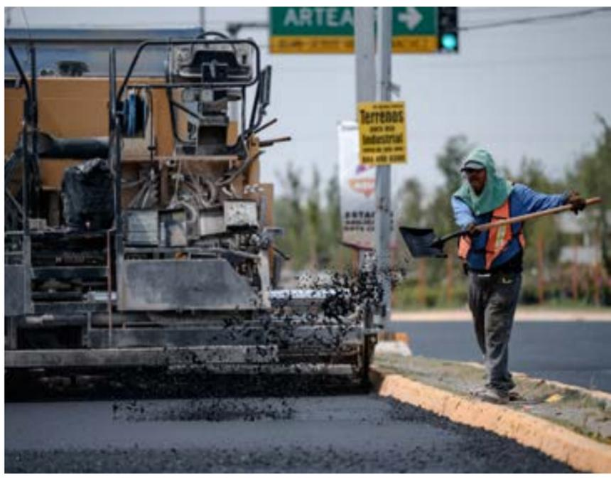
litará además el pavimento de concreto asfáltico en el lateral nororiental para posteriormente aplicar pintura termoplástica en encauzamiento de carriles, así como colocación de señalización
