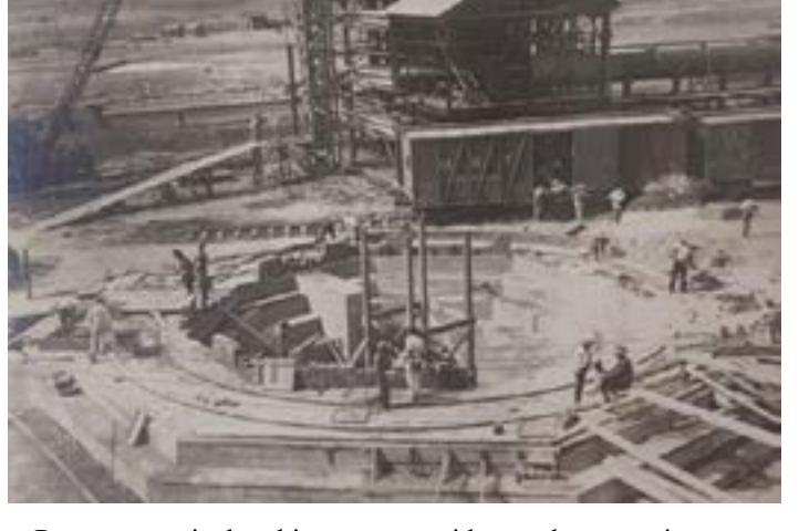
Para construir la chimenea de 137.5 metros de altura se colocó una base en espiral para que los trabajadores pudieran subir y bajar sin problemas destacando que no hubo muertos o lesionados gravemente heridos.
